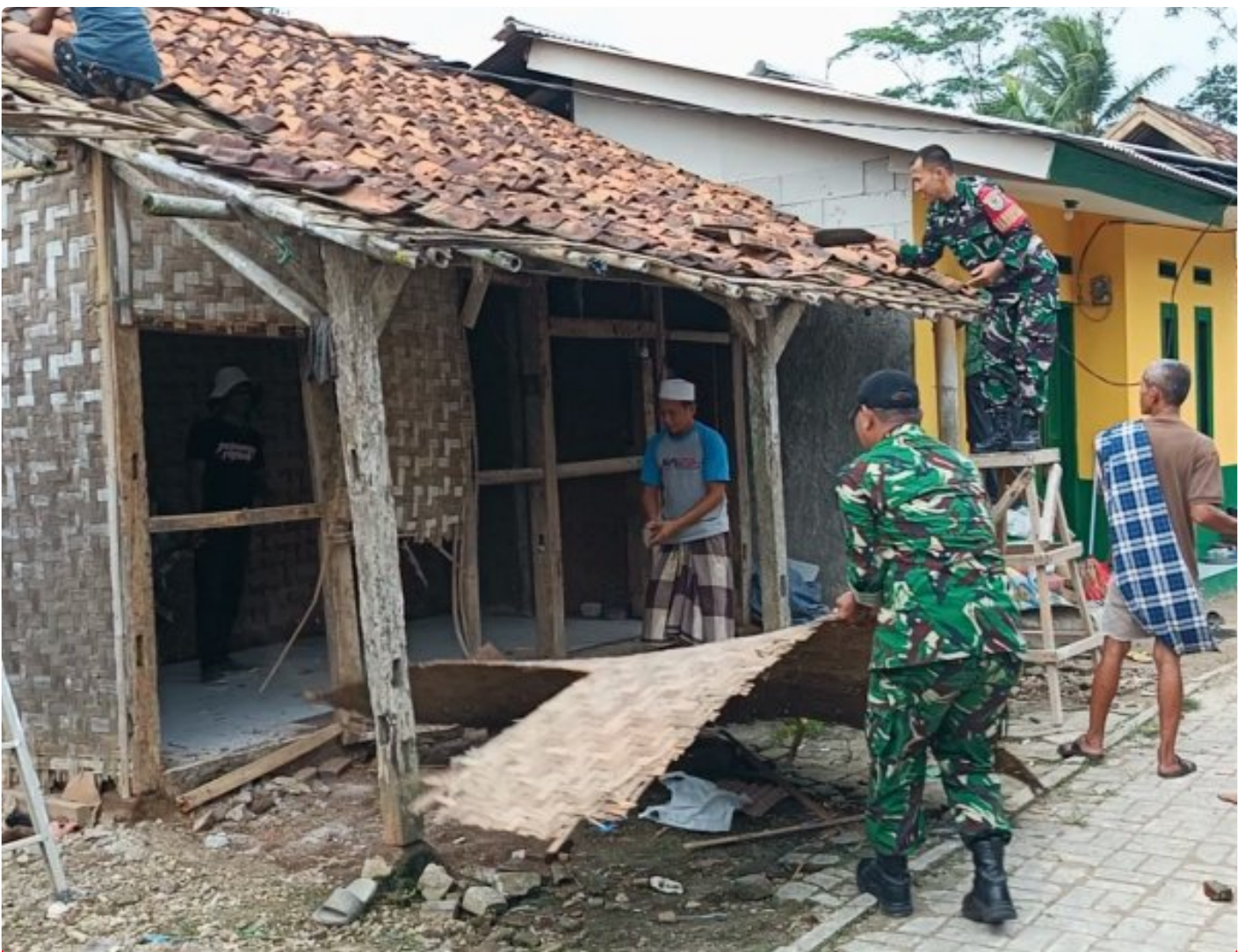
Pembongkaran Rumah Bapak Narmin
